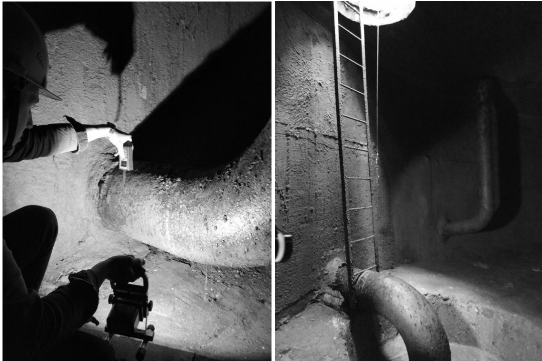
Рис. 2. Фотографии с обследования резервуаров
